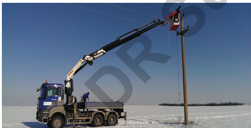
Lucrări de mentenanță linii electrice aeriene - Domarex `94 Călărași
