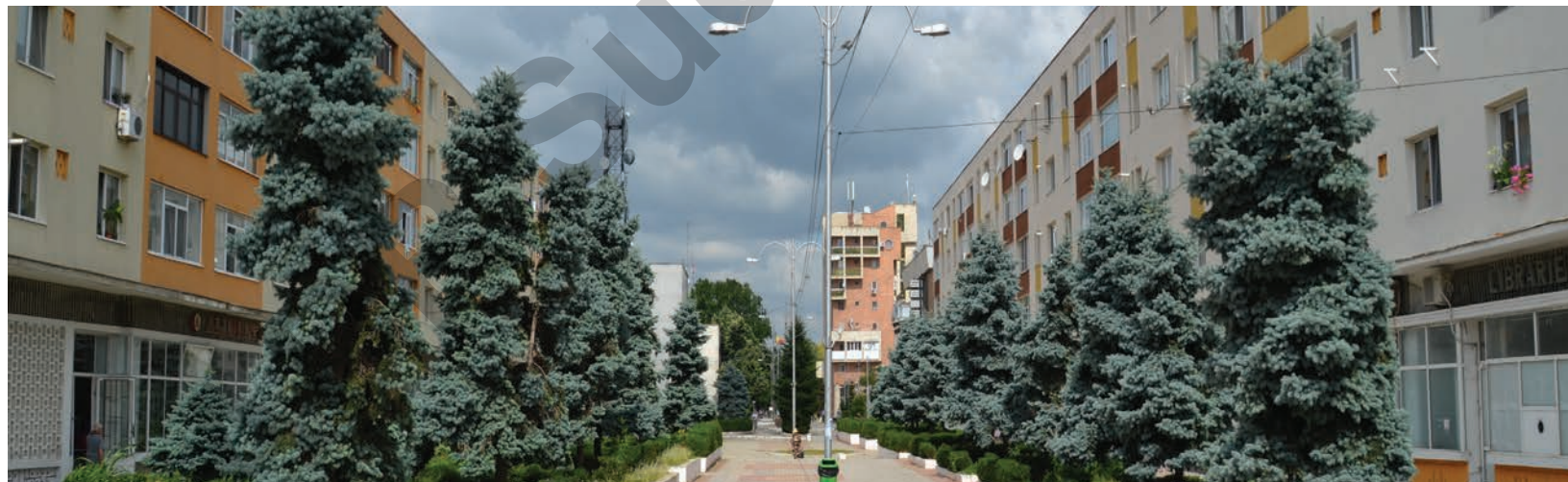
Blocuri reabilitate - Centrul vechi al municipiului Călărași
