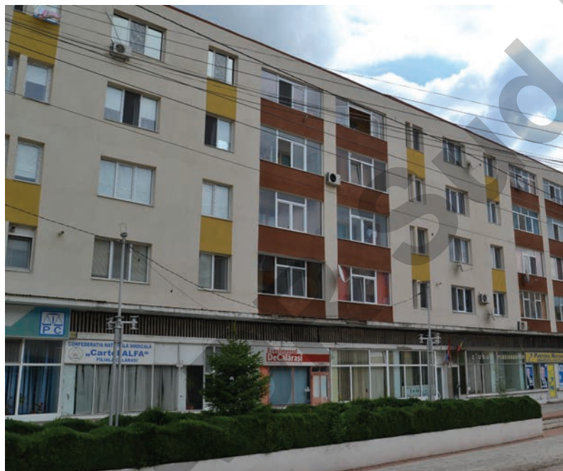
Blocurile A20, A21, A23 din Centrul vechi al municipiului Călărași
