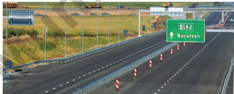
Autostrada 2 - București - Constanța
