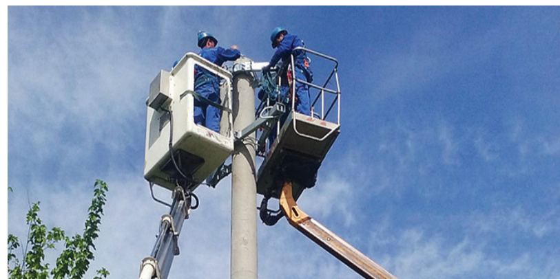
Realizare linie electrică aeriană - Domarex `94 Călărași
